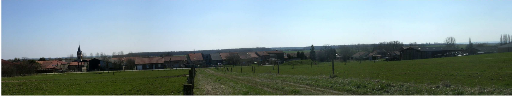
Vue depuis le chemin rural de Lavaux vers la Grande Rue présentant la typologie d'un village-rue lorrain. Une homogénéité est assurée par les toitures dont les faitages sont parallèles à la rue.
